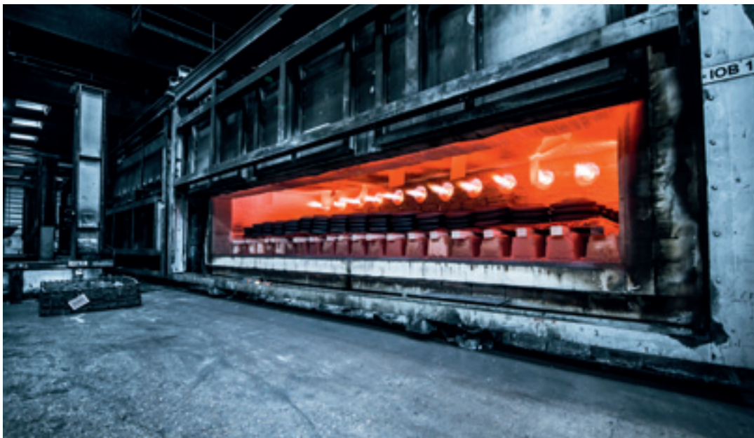
Ebenfalls Teil des Leistungsspektrums der GABO STAHL-Gruppe: prozesssichere Warmbehandlung von Stählen und Schmiedeteilen.
